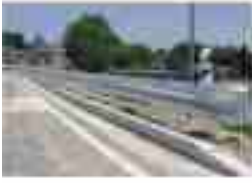
STEEL GUARDRAIL 가드레일
